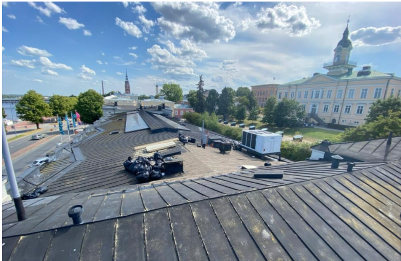
Kuva 4: Vesikaton tilapäinen korjaus.
