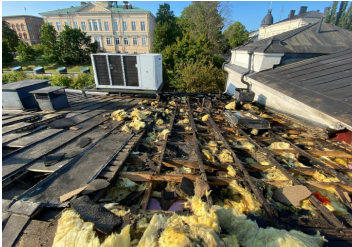
Kuva 3: Yläpohjan palovahinkoalue.
